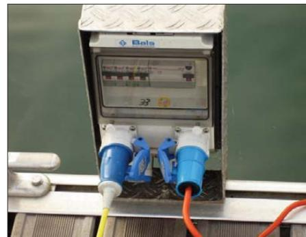
**Bild 8: Ein spritzwassergeschützter Anschlusskasten für 230 V vom Land**
